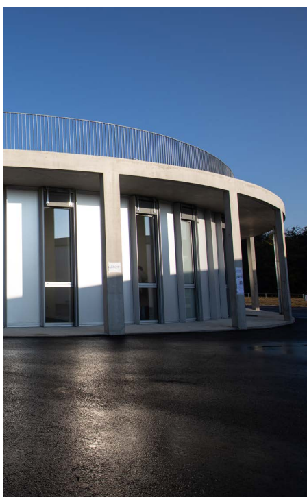
Site Instrumental de Recherche par Télédétection Atmosphérique
